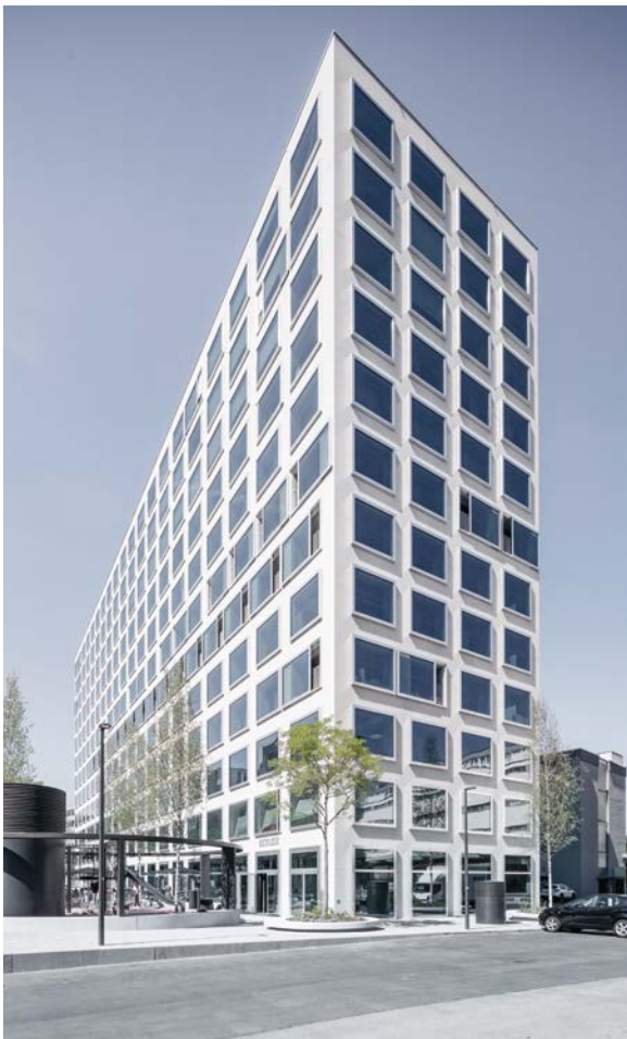
Diakonie Bethanien, Zurich Hauteur: 40 m Éléments coulissants: 500 Prestation: enveloppe complète de la façade
