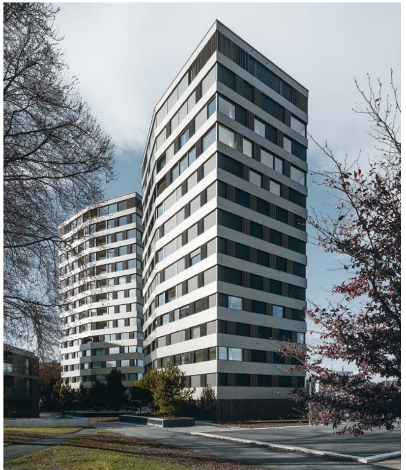
One-One, Cham Höhe: 46 und 49 m Schiebelemente: 58 Leistung: komplette Fassadenhülle
